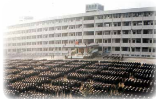
(圖七) 1984年竣工後四維樓與學生升旗照
